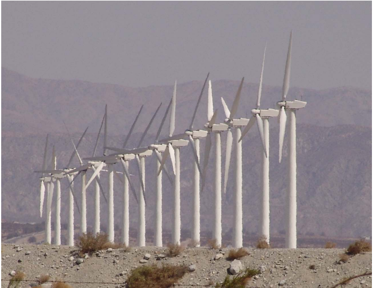
Windkraftanlagen vor den Toren von Palm Springs - USA
